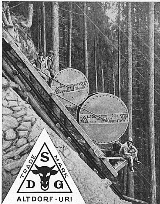
Verlegung der Bleikabel für KW-Sernf-Niederenbach. Pose des câbles sous plomb pour la Centrale de Sernf-Niederenbach
