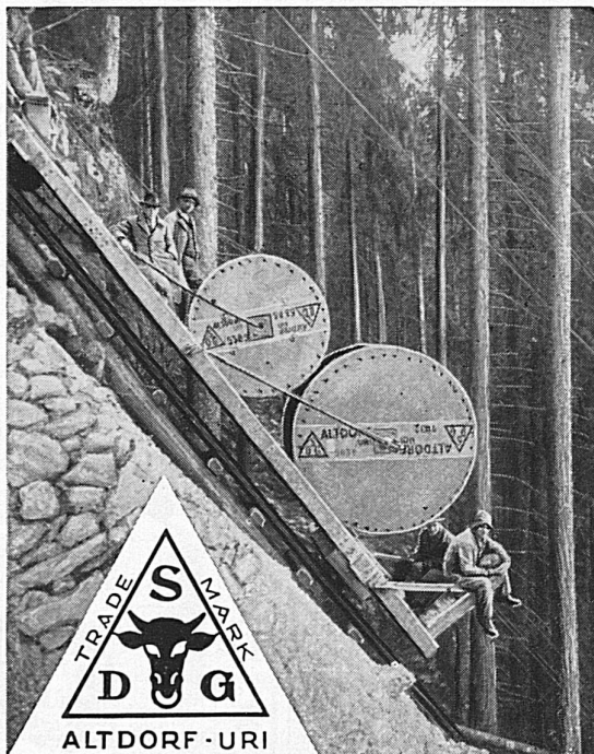
Verlegung der Bleikabel für KW-Sernf-Niedererbach. Pose des câbles sous plomb pour la Centrale de Sernf-Niedererbach
