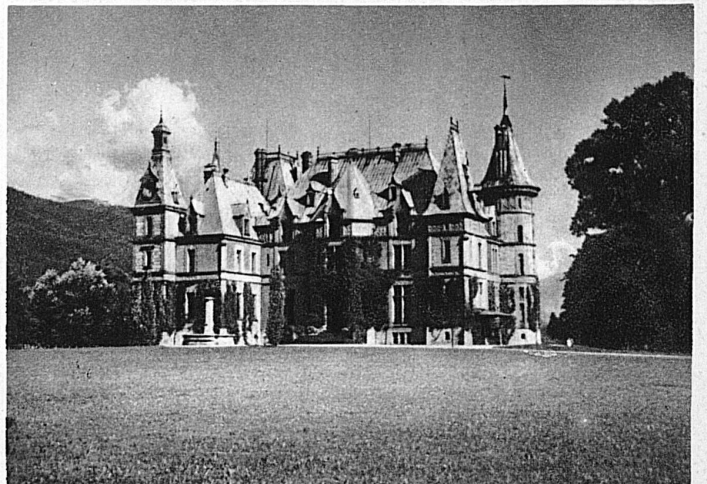
Le château de Schadau et son parc public
