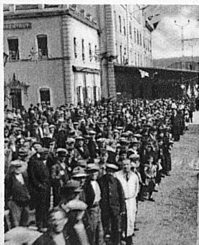
Alles will den Einzug der elektr. Lokomotive sehen
