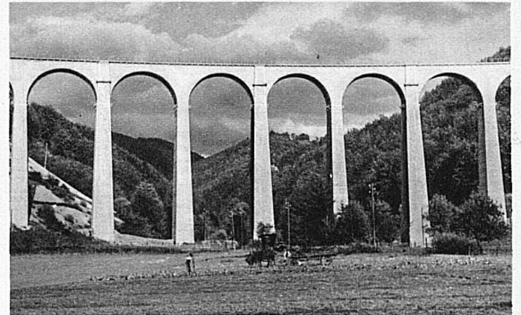
Der mächtige SBB-Viadukt bei St. Ursanne wurde für die Elektrifikation in eine Betonbrücke umgebaut
