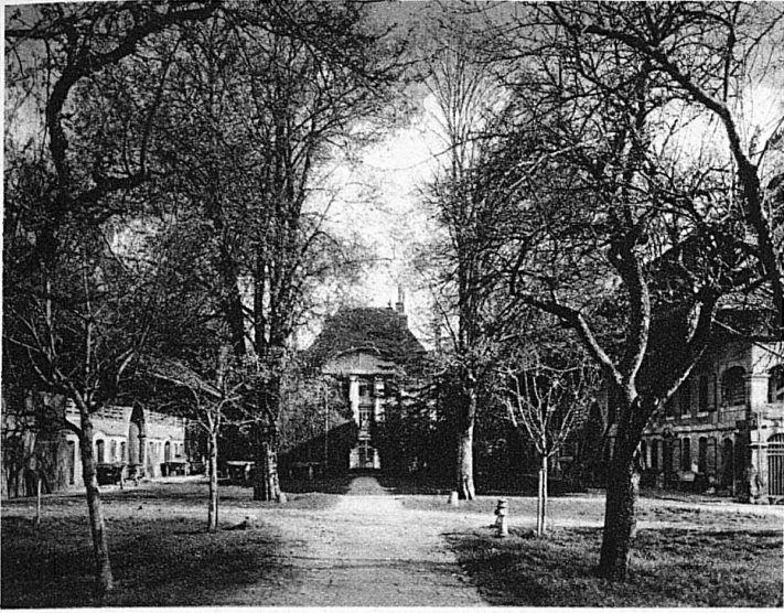
Le «Mettlengut» à Muri. Presque tous les domaines bernois comportent, à une certaine distance l'une de l'autre, une maison de maîtres et une ferme. Ici, elles sont juxtaposées, ce qui forme un ensemble architectural plein d'originalité: de chaque côté deux imposantes granges et, fermant l'avenue, le château.
