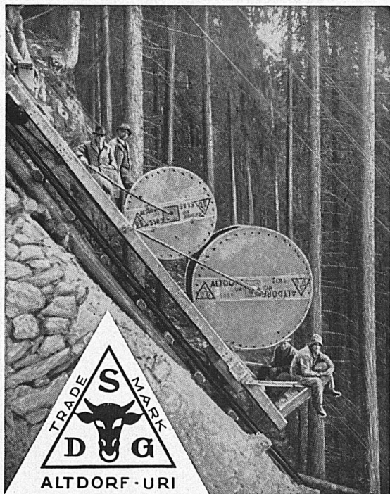
Verlegung der Bleikabel für KW-Sernf-Niederembach. Pose des câbles sous plomb pour la Centrale de Sernf-Niederembach
