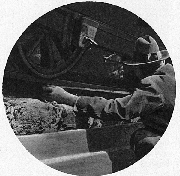
Bei den Bremsproben. Ein Wagen, voll belastet, wird vom Seil gelöst und hängt nur an einer Kette. Das Kontrollpersonal wartet auf den Moment, wo er, jeder Führung bar, lossaust und automatisch auf einer bestimmten Strecke, dem «Bremsweg», anhalten muss. Die Länge dieses Bremsweges ist vom Eisenbahndepartement genau festgelegt. Unten: Ein Ingenieur beim Messen des Bremsweges
