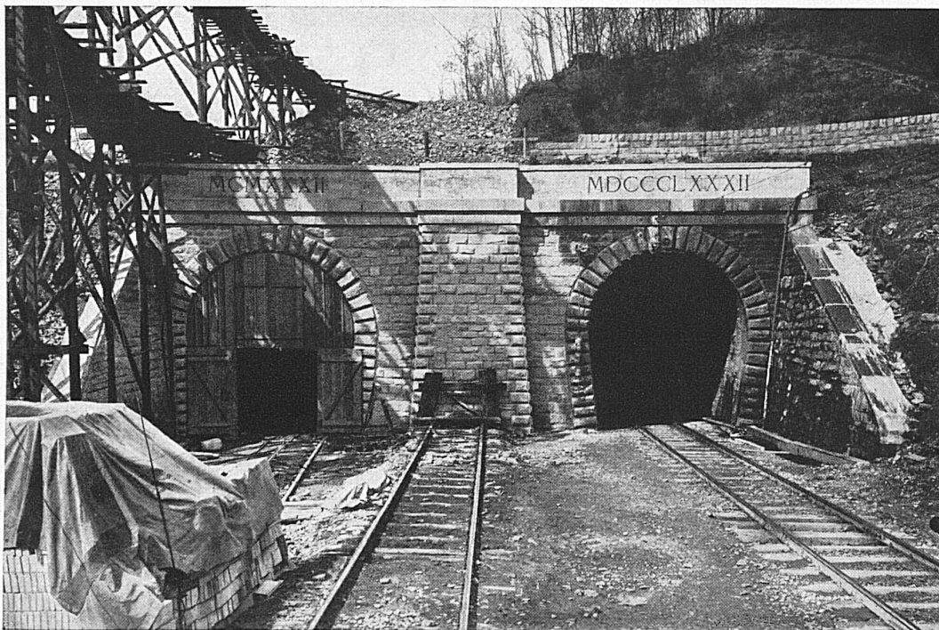
SBB Ceneri-Tunnel, Südportal
