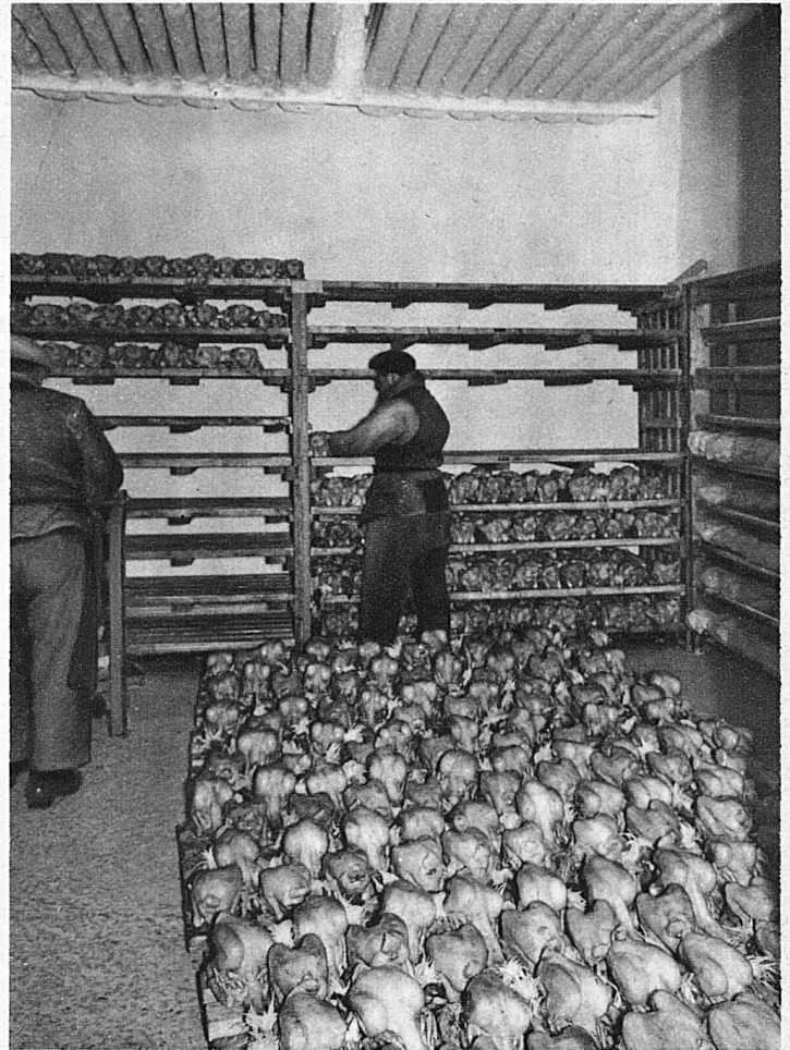
Blick in einen Geflügelraum des Bahnhof-Kühlhauses Genf
