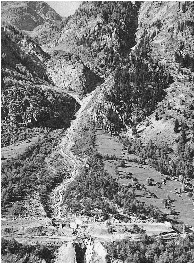
Oben: Der Blattbach und seine Lawine zerschmetterten jedes Jahr die Brücke. Ein Tunnel schützt jetzt Bahn und Geleise
