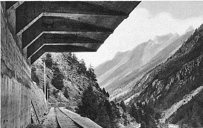
Unten: Die Galeriedecke bei der Schusslauri muss besonders stark gebaut sein
