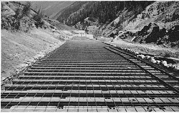
Oben: So ist der Tunnel bei Lugelwang eingedeckt worden
