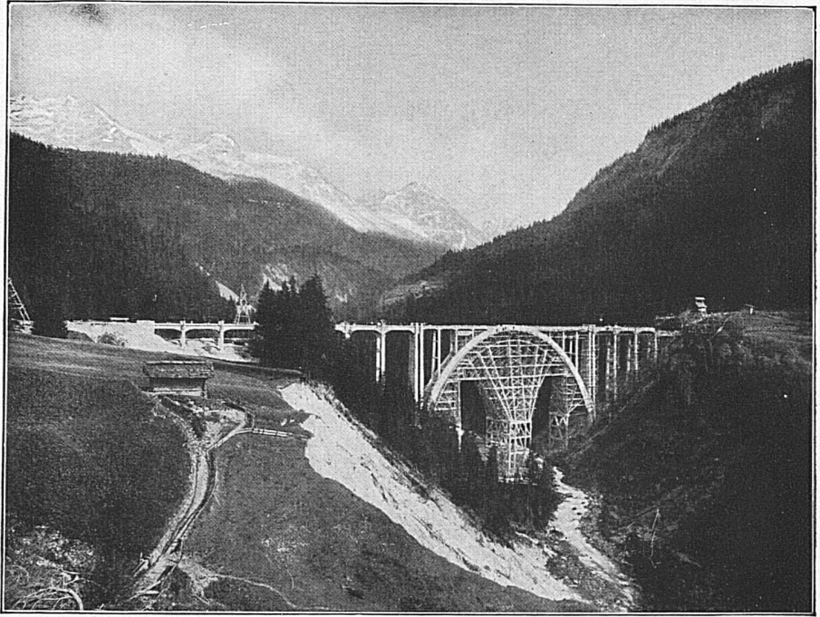
Viadukt bei Langwies während der Bauausführung
