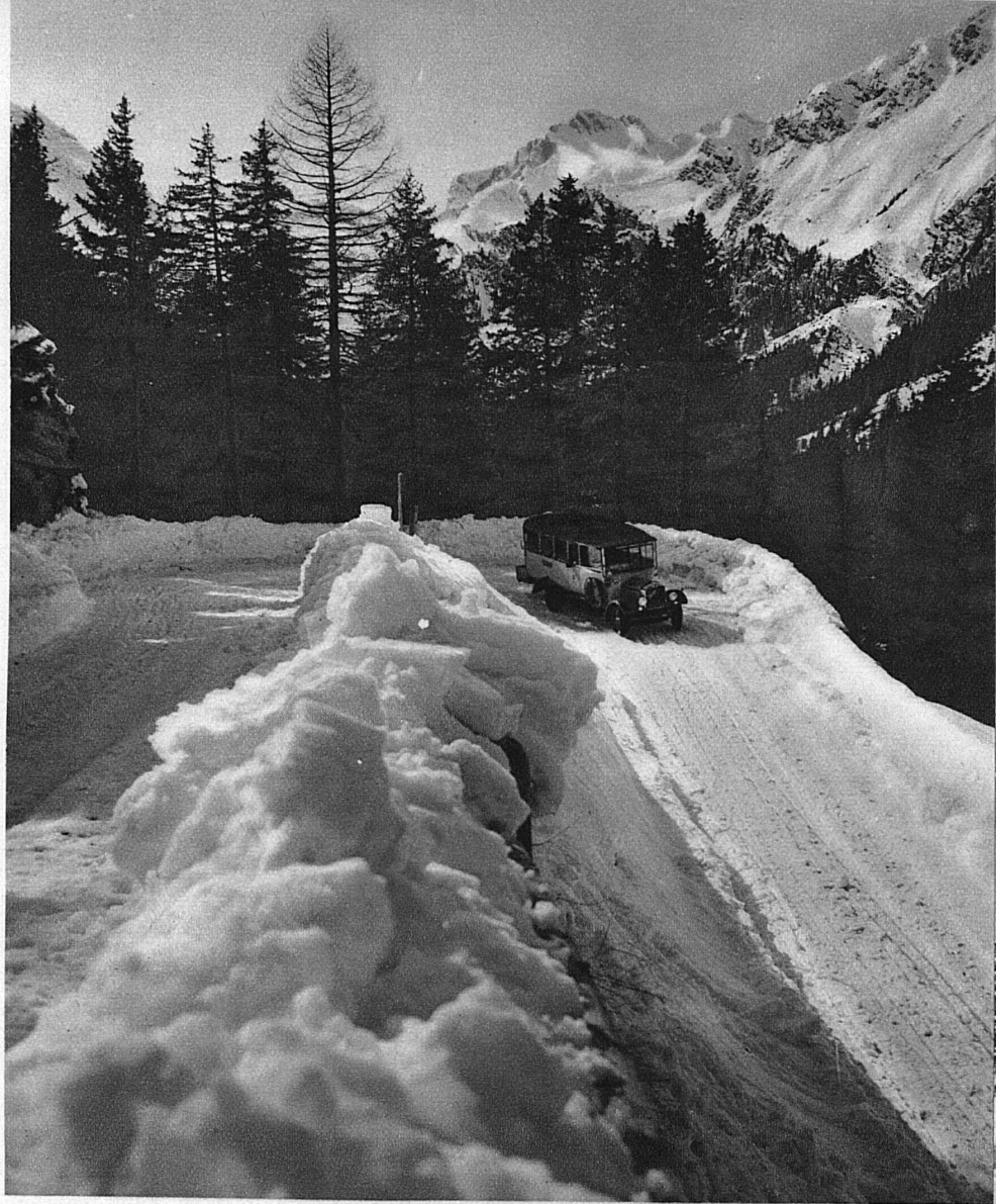
Das Postauto in den Kehren der Malojastrasse
