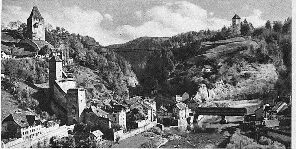
Die alte turm- und mauerbewehrte Zähringerstadt Freiburg
