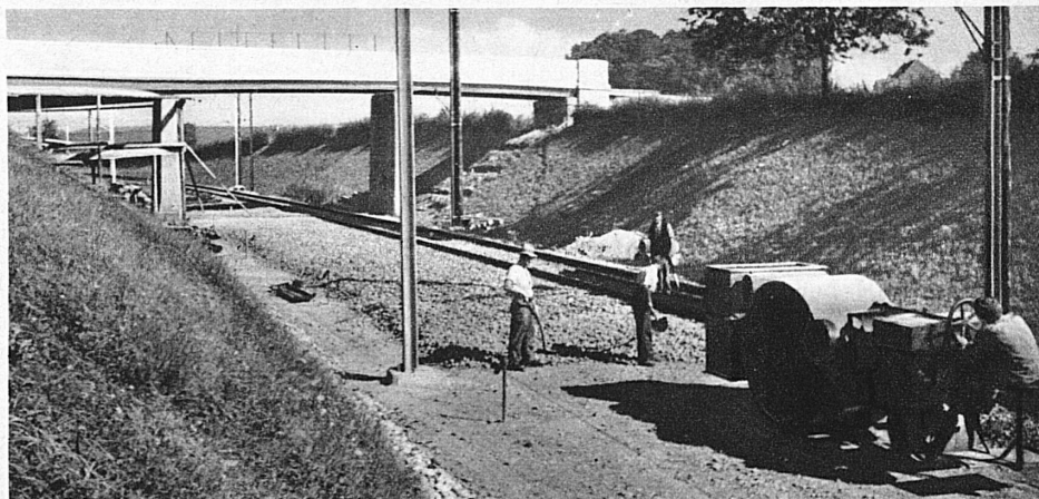
Vor der Aufnahme des Schotterbettes wird das fertiggestellte Planum tüchtig gewalzt
