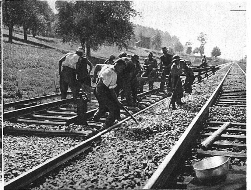
Das auf Eisenschwellen fertigverschraubte Geleisestück wird auf Tragrollen vorgeschoben
