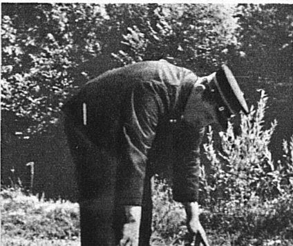
Kontrolle der Spurweite
