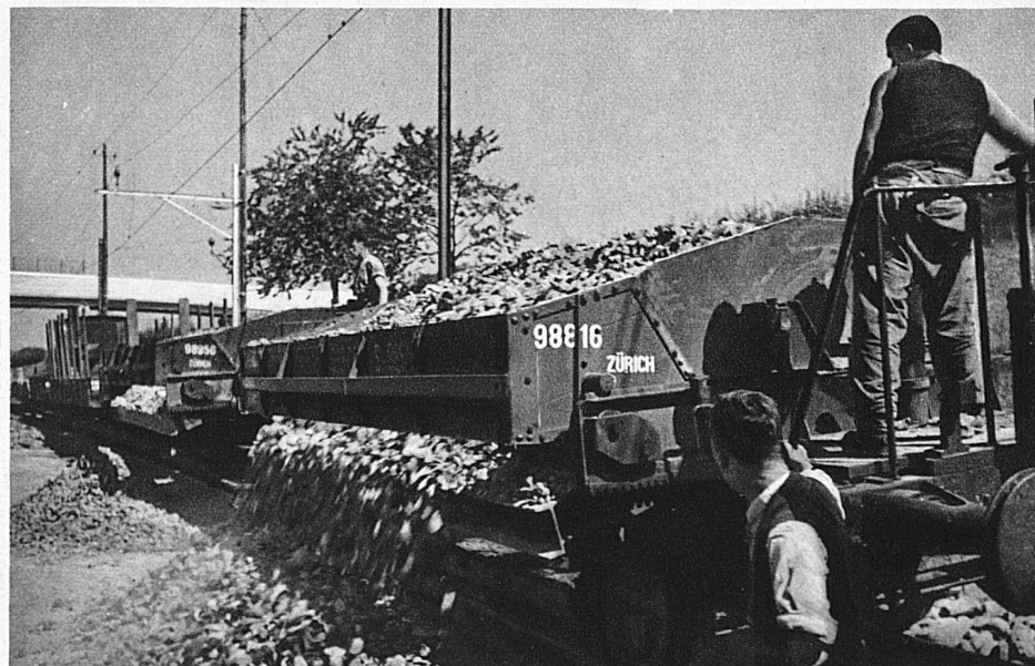
Ein Materialzug bringt den Schotter für die Geleisebettung
