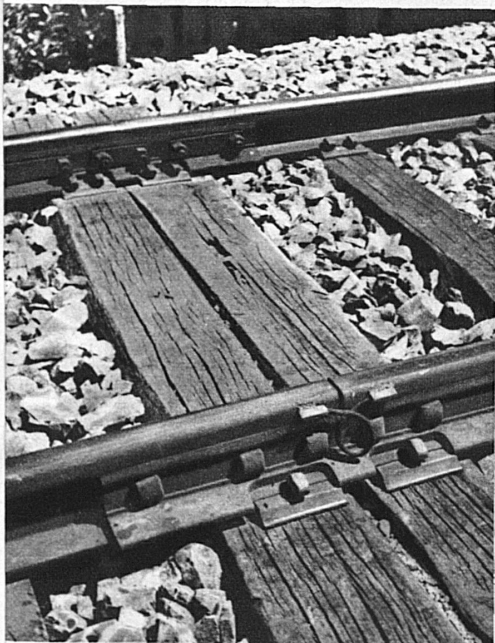
Schienenstoss mit elektrischem Schienenverbinder
