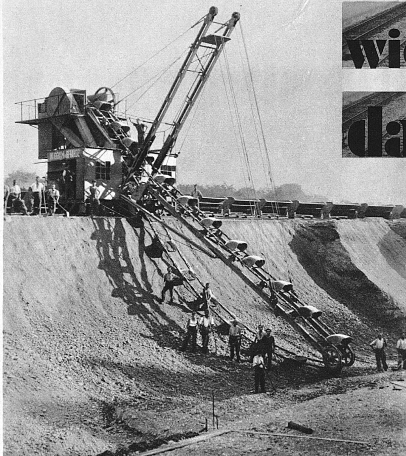
Ausheben eines Einschnittes durch einen Löffelbagger. Das ausgehobene Material wird durch Rollwagen abgeführt
