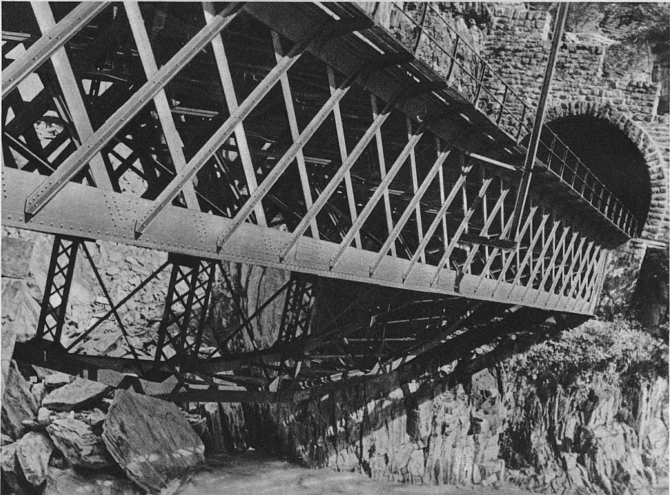
Eines der zahlreichen Beispiele, wo nach dem Tunnel eine Brücke folgt, dann ein künstlicher Damm und so weiter, Bauwerk an Bauwerk
