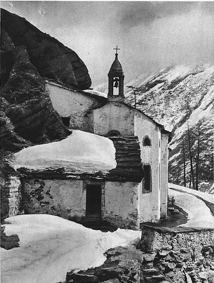
Eine Kapelle am Saumweg bei Saas-Grund, die sich in den Lawinenschutz der Felswand schmiegt
