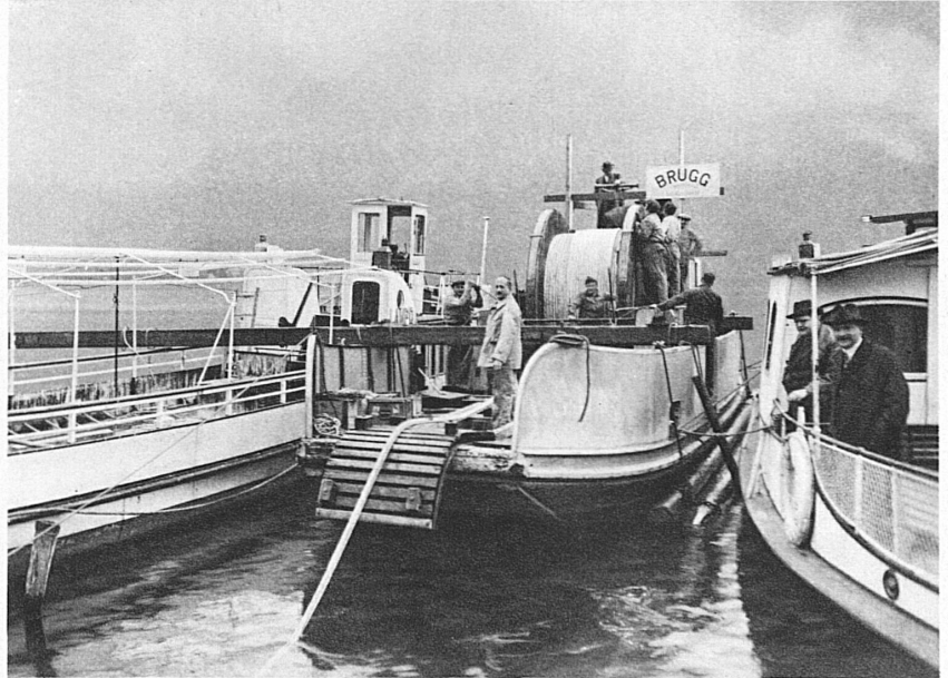
Verlegung eines Telephonkabels im Luganersee zwischen Morcote und Brusino für die Post- und Telegraphenverwaltung. November 1934
