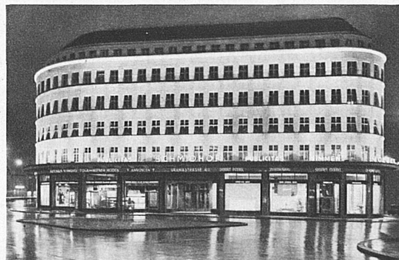
Geschäftshaus Schmidhof, Zürich
