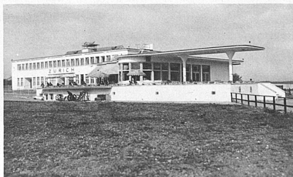
Grossrestaurant Zivillflugplatz Dübendorf Architekten: Kündig & Oetiker, Zürich
