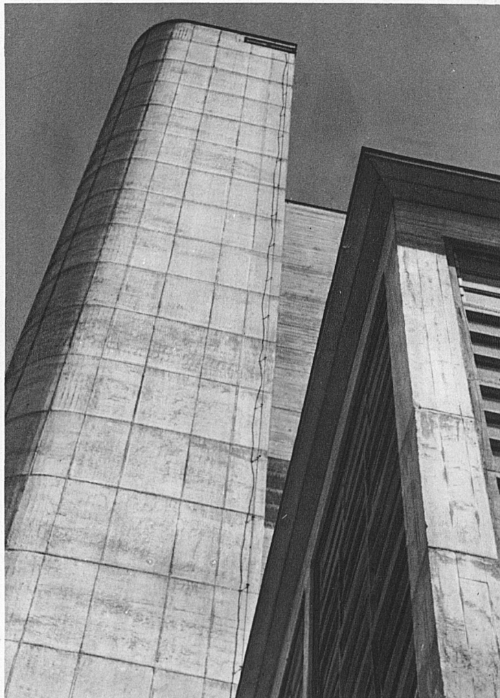
Der Fernheizungsturm der Universitätsbauten, Zürich
