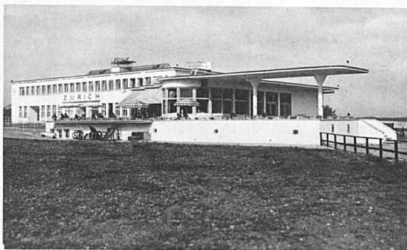
Grossrestaurant Zivilflugplatz Dübendorf Architekten: Kündig & Oetiker, Zürich
