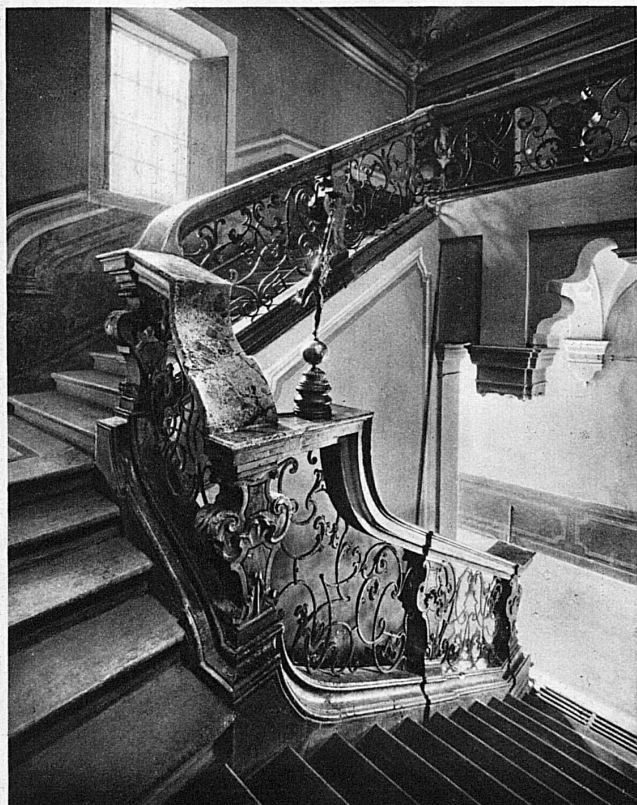
Lugano: Scalone del Palazzo Riva — L'escalier du Palazzo Riva à Lugano — Treppe im Palazzo Riva in Lugano — Staircase in Palazzo Riva, Lugano
