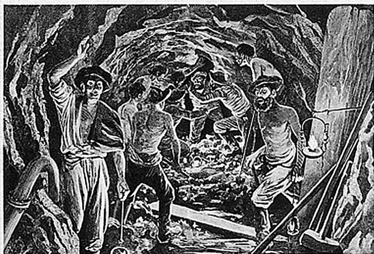
Tunneldurchstich am Gotthard im Februar 1880 – Percement du tunnel du St-Gothard, en février 1880
