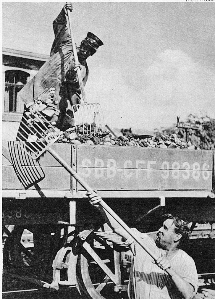
Der verschmutzte Altschotter findet neue Verwendung beim Strassenbau — Le vieux ballast sera remployé sur les routes
