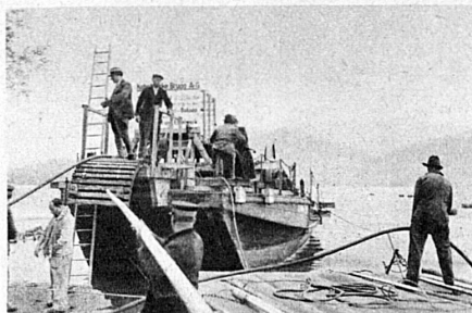
Verlegung eines Telephonkabels von 2620 m (in einer Länge) und 30 Tonnen Bruttogewicht durch den oberen Zürichsee zwischen Rapperswil und Lidwil (Schwyz) - Einzelwerk - für die Schweiz. Bundesbahnen. 17. Aug. 1937. Anknüpft des Verlegeschiffes in Rapperswil
