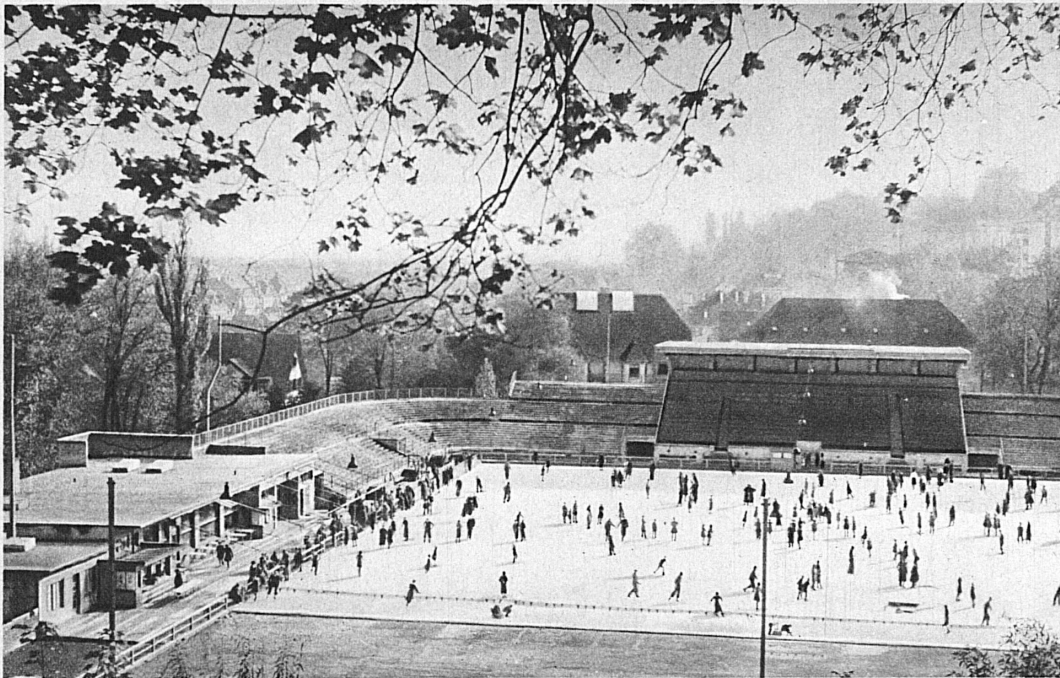
The artificial ice rink at Basle at the opening of the present season (October 30 th ) — L'ouverture de la saison à la patinoire artificielle de Bâle, le 30 octobre 1938 — Die Basler Kunst-eisbahn bei der Eröffnung der Saison 1938/39 am 30. Oktober
