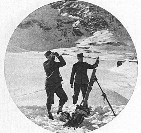
Threatening avalanches are artificially brought down on the Bernina Railway route — Détachement d'une avalanche artificiellement provoquée sur la voie du chemin de fer de la Bernina — Auf der Berninabahnstrecke werden Lawinen künstlich zur Loslösung gebracht
