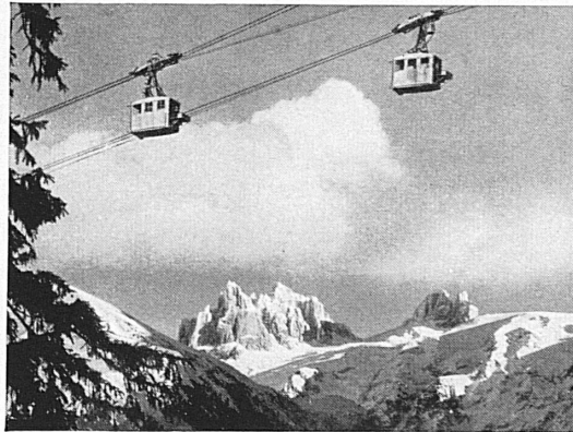
Luftseilbahn Gerschnialp-Trübsee mit Spannörtern
