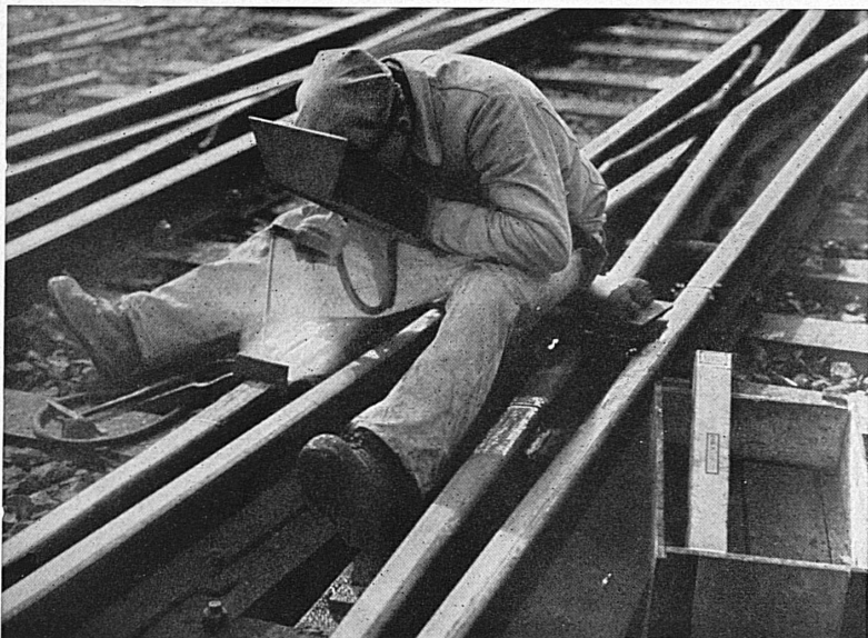
Unterhalts-Schweißarbeiten in einem SBB-Bahnhof
