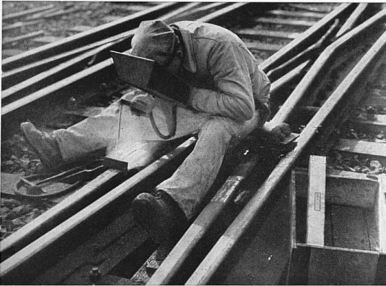
Unterhalts-Schweißarbeiten in einem SBB-Bahnhof
