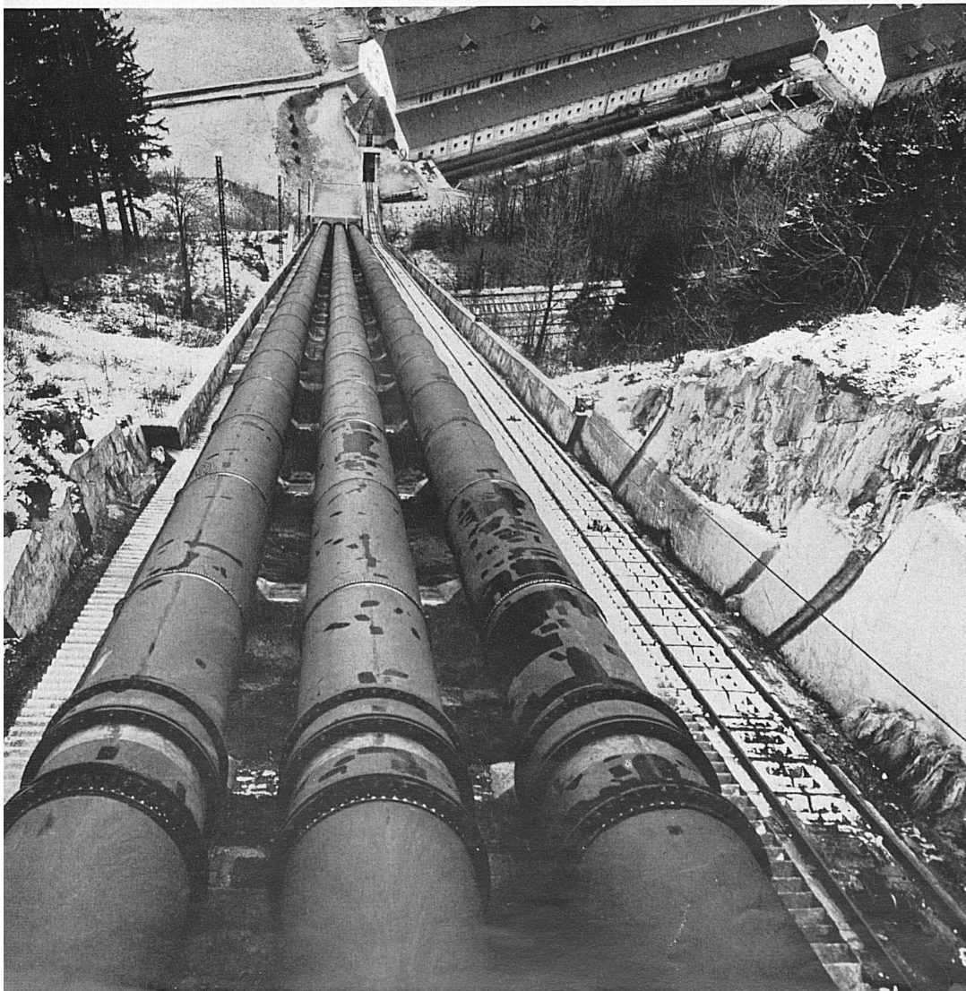
Das SBB-Kraftwerk Amsteg an der Gotthardlinie.* L'usine électrique des C. F. F. à Amsteg sur la ligne du St-Gothard.
