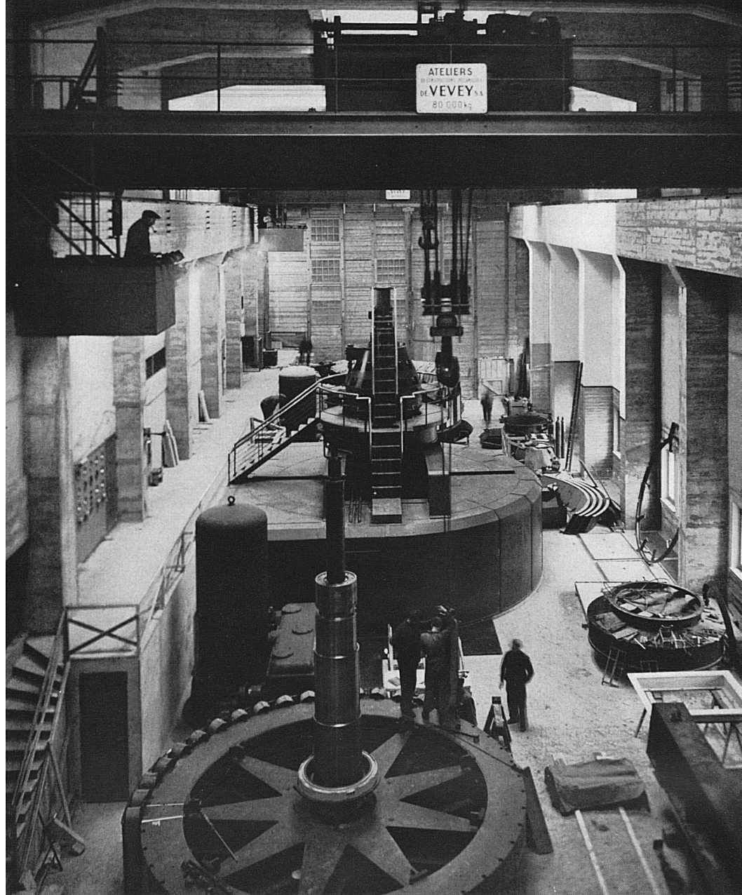
L'usine du Verbois, une partie de la salle des machines avec le premier groupe générateur (31500 CV). Teil der Maschinenhalle in Verbois mit der ersten Generatorgruppe zu 31500 Pferdestärken.
