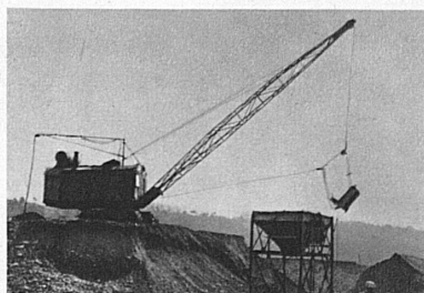
Draglines, flèche 20 m.
