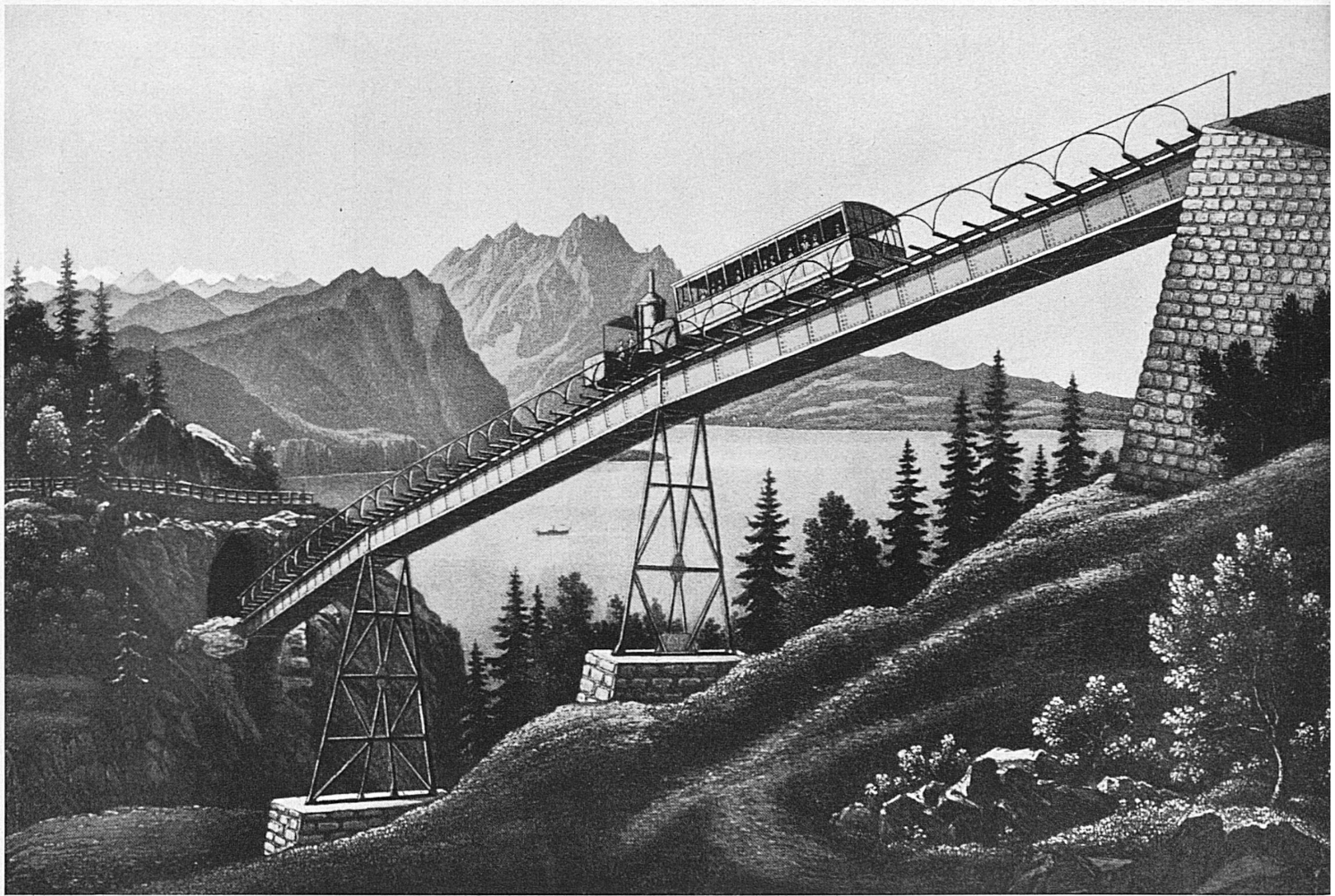
Schnurrötelbrücke zur Zeit der Inbetriebnahme der Bahn. Stich von Dikemann. Schnurrötelbrücke, à l'époque de la mise en service du train. Estampe de Dikemann.
