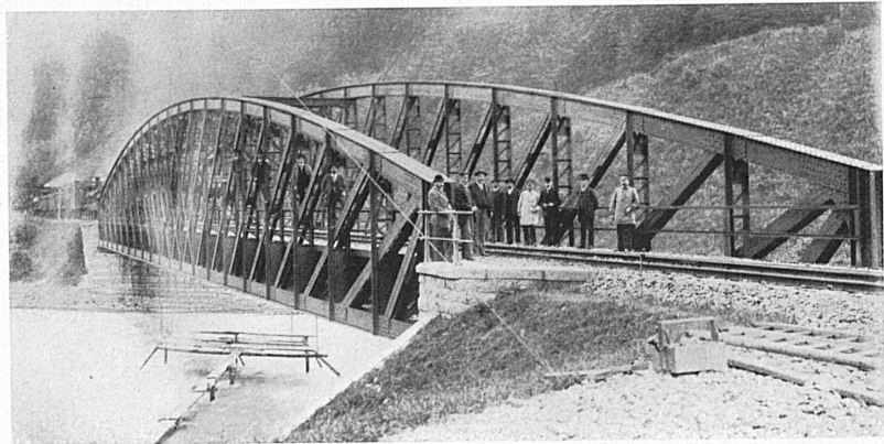
Rechts: Brückenprobe der eisernen Sihlbrücke bei Sihlbrugg im Jahre 1897. — Unten, von links nach rechts: Gotthardschnellzug zwischen Luzern und Meggen; im Hintergrund der Pilatus. Die Strecke ist auch Teilstück der «Direkten» Luzern—St. Gallen. — Auf der nunmehr 50jährigen «direkten» Nordzufahrt zum Gotthard bei Oberrieden; Blick auf den Zürichsee. Photo: Villiger, Klausner.
