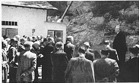
Oben: Herr Frey-Fürst erklärt den geladenen Gästen anlässlich der Eröffnung das kleine, geschickt angelegte Elektrizitätswerk. — En haut: M. Frey-Fürst fournit des explications aux invités sur la petite usine électrique judicieusement installée et qui vient d'être inaugurée.
