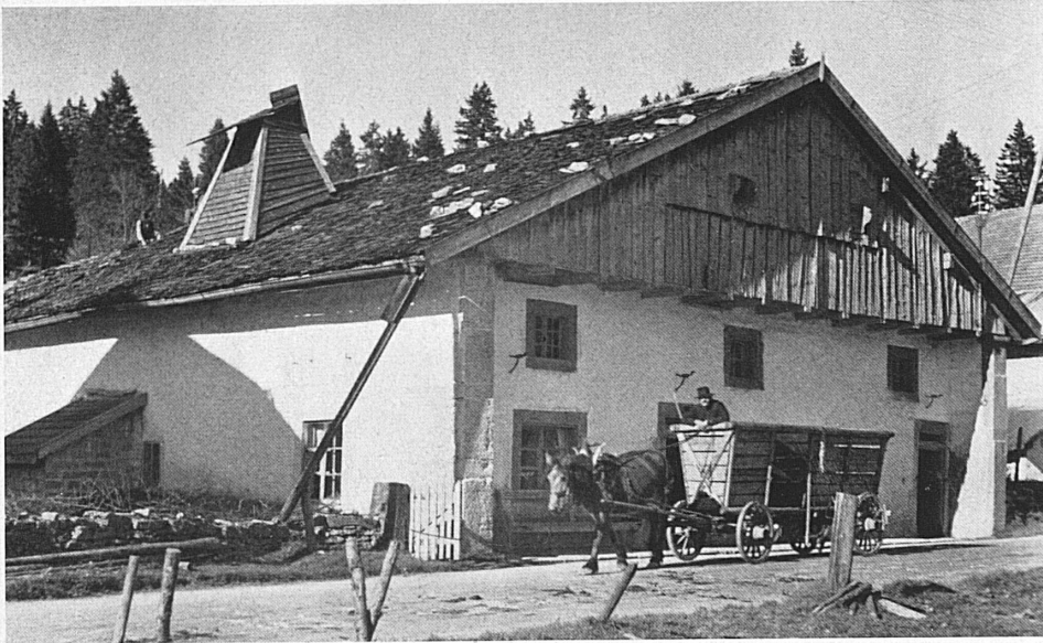
Oben: Jura-Haus mit Deckelkamin in La Corbatière (Neuchâtel). — Ci-dessus: A la Corbatière (Neuchâtel), maison jurassienne avec cheminée à couvercle. Photo: Maurer.
