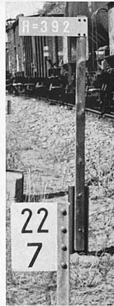
Der Radienzeiger (obere Tafel), der den Radius der betreffenden Kurve in Metern, sowie die Hektometertafel (im Bild unten), die die Distanz von der Ausgangsstation der betreffenden Linie angibt, sind für Bahnbau und -betrieb wertvolle Merkmale.
