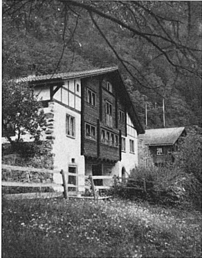
En haut: A Silenen (Uri) s'élève la « Sust », ancien péage de la route du Gothard, dont la charpente en bois s'allie de façon originale à la pierre et aux colombages. — Oben: Die alte Sust in Silenen (Uri) wurde kürzlich renoviert und zeigt eine eigenartige Verbindung von Blockbau, Mauern und späterem Fachwerk.
