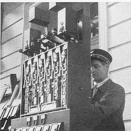
Links: Stellwerkmonteur Kramer revidiert als allezeit gern gesehener Gast in der Station den elektrischen Streckenblockapparat, auf dem die Sicherheit des Bahnverkehrs zum guten Teil ruht.
