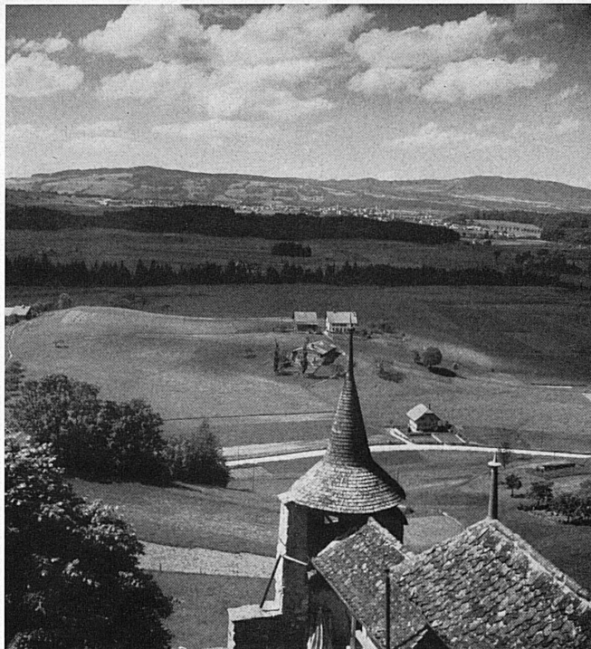
Ci-dessus: Vue des remparts de Gruyères en direction de Bulle. Oben: Ausblick von den Ringmauern des Städtchens Gruyères gegen Bulle. Photo: Chiffelle
