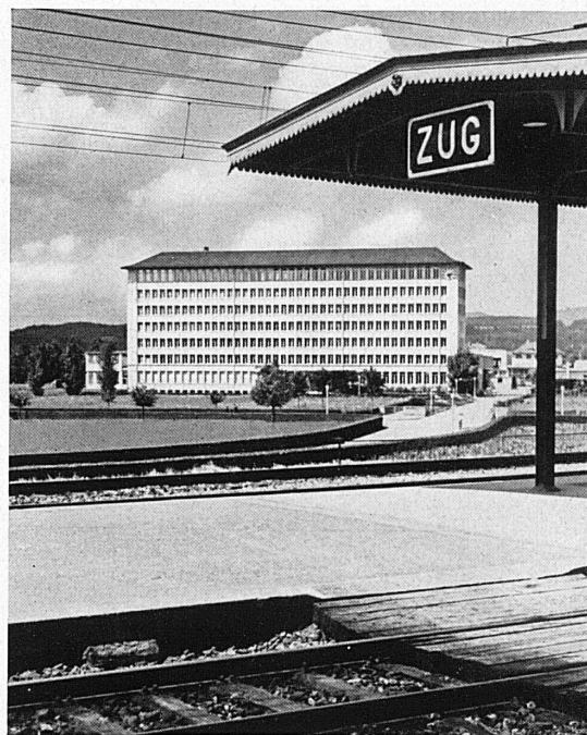
Werk Gubelstraße der Landis & Gyr AG, Zug Fabrik für Elektrizitäts-Zähler und Apparate
