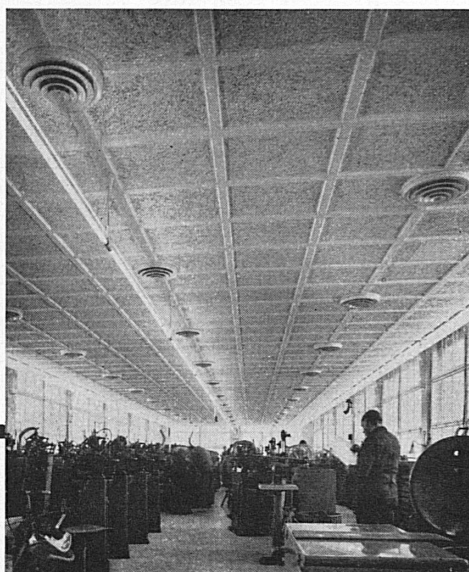
Klimaanlage «System Häusler» in Uhrenfabrik
