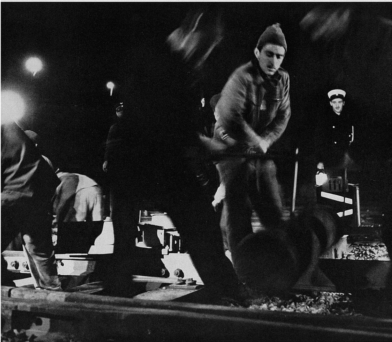
*Nach der Entfernung der alten Weicheneinheiten werden die neuen Weichenteile mit den Kranen präzisiert an die vorausberechneten Stellen verlegt (Bild rechts). Für die letzten Feinheiten aber (Bild oben) ist wiederum die manuelle Arbeit der Bahndienstströten unerlässlich.*
