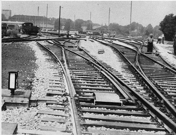
Ausbau Basel GB
