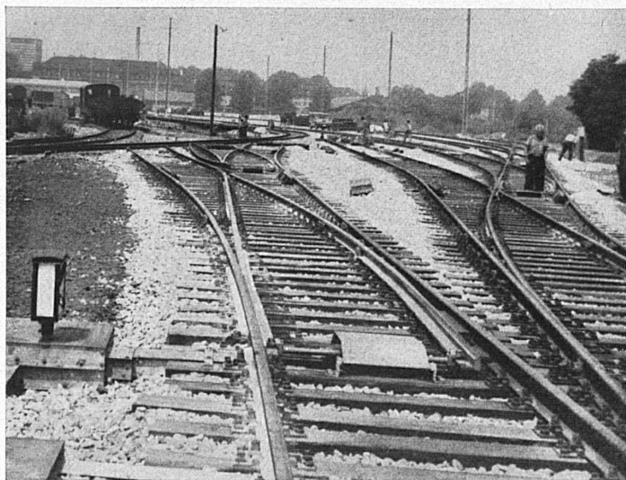
Ausbau Basel GB
