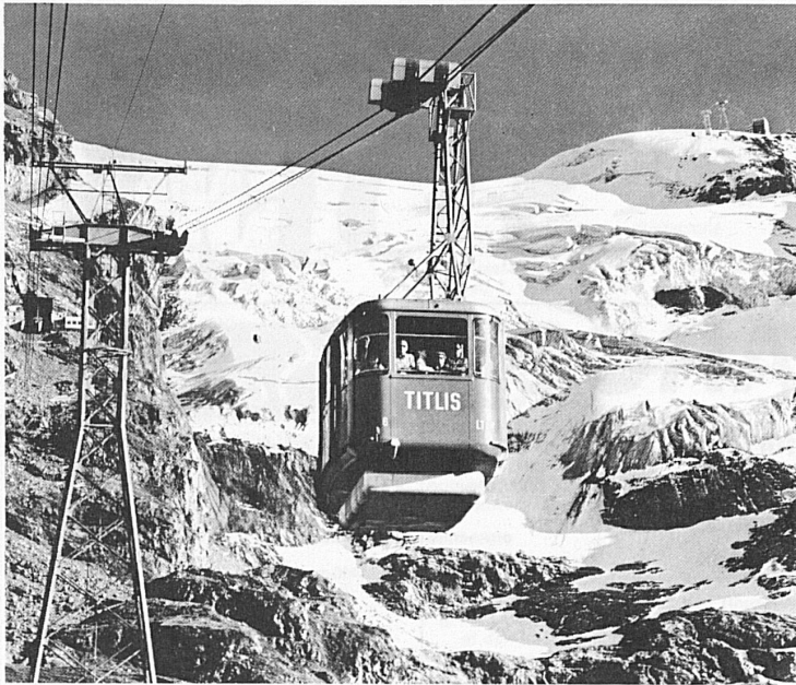
Bergbahnen Télécabliques Aerial cableways Engelberg-Trübsee-Stand-Titlis
