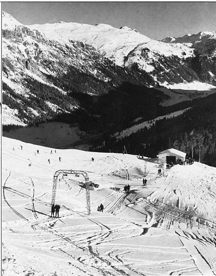
Skilift Splügen-Tanatz (Foto L. Gensetter, Davos)
