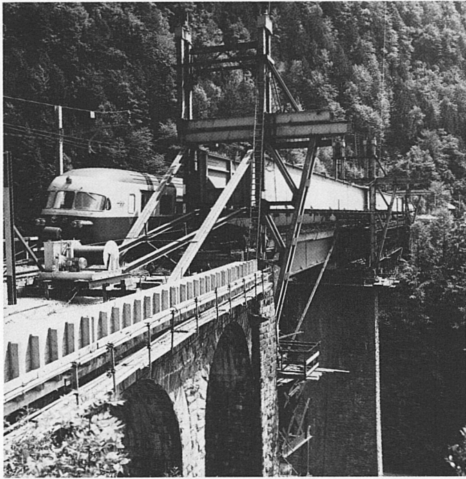
Umbau der Kerstelenbachbrücke 1970. Die vorfabrizierten, 3 m hohen, vollwandigen Stahlträger werden über die alten Eisenfachwerkträger geschoben, diese daran aufgehängt und demontiert. Dann können die neuen Träger in ihre endgültige Lage abgesenkt werden. Während des ganzen Umbaus ging der Bahnbetrieb einspurig weiter. Photos SBB
