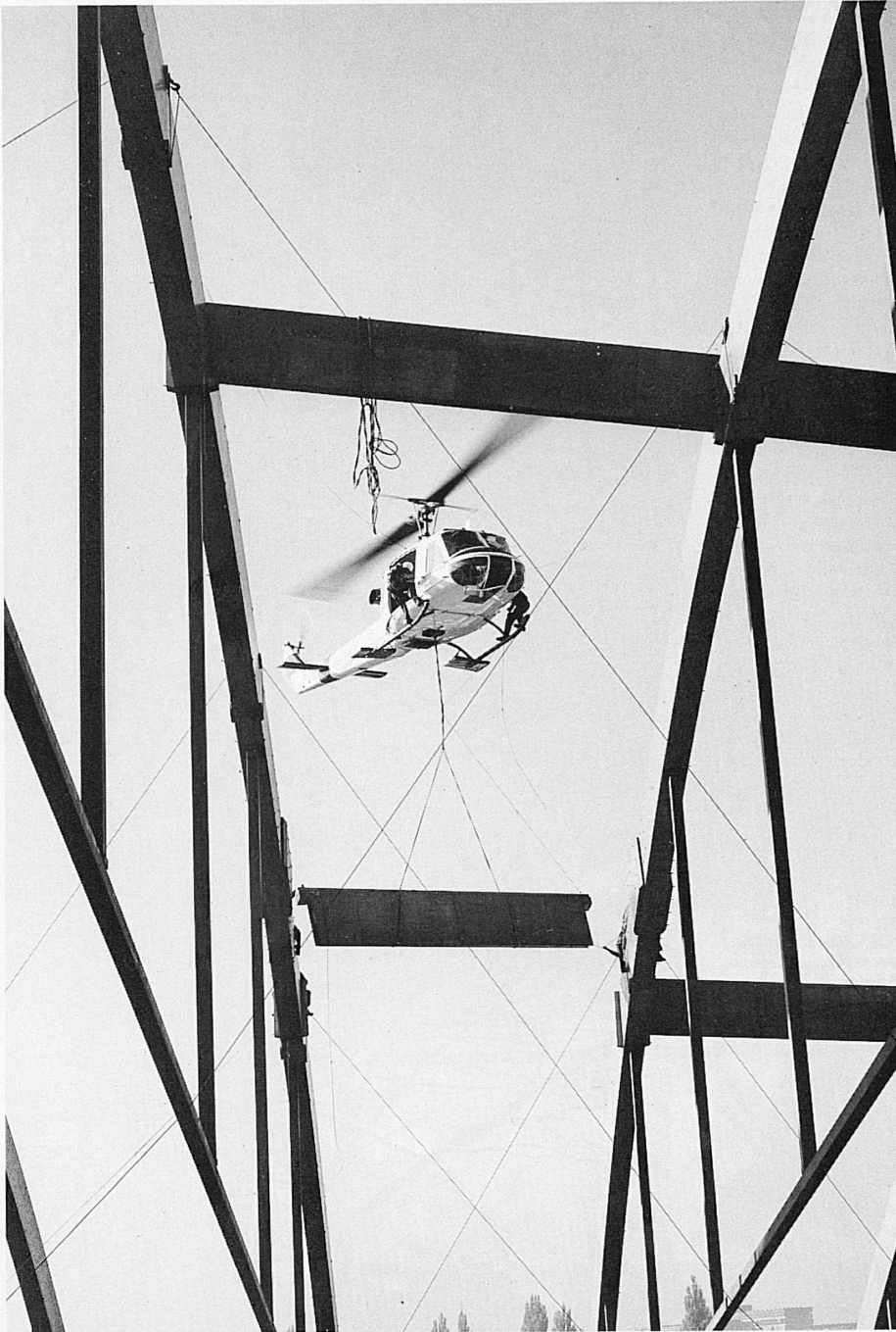
Oben: Kunsteisbahn-Halle in Bern. Montage der Holzkonstruktion mit Helikopter. Photo W. Studer. Unten: Hallenschwimmbad Gstaad. Verleimtes Brett-schichtholz widersteht den Einflüssen des Klimas einer Schwimmhalle. Photo Fäh. Rechte Seite: Ohne Holz geht es selbst beim Bau einer Spannbetonbrücke nicht! Montage des Lehrgerüsts der Monbijoubücke in Bern. Photo W. Studer
