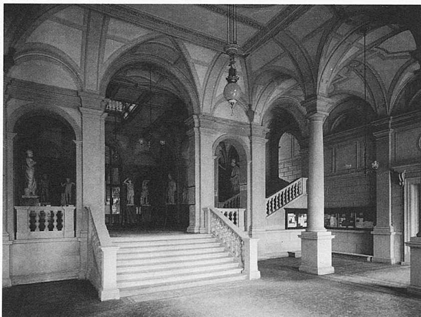
Hauptvestibül der ETH Zürich, erbaut von Gottfried Semper in den Jahren 1860–1864. Das «römische Atrium» war konstruktiv nur möglich mit einer versteckten Eisenkonstruktion der Decke
