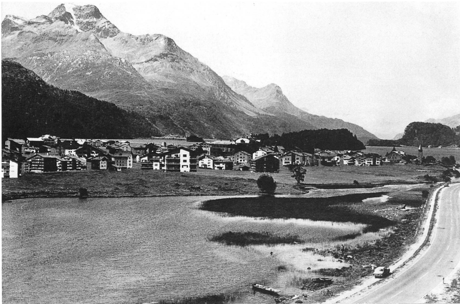
So hätte die Silser Ebene nach der Bauzone von 1963 überbaut werden können. Zum Glück bleibt diese böse Vision nur Photomontage
